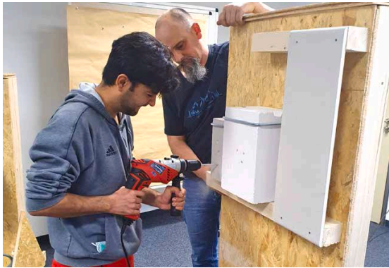
Wandverschraubungen, die dauerhaft halten. Dank Praxisanleitung kein Problem.
