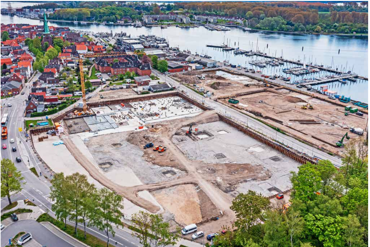
Luftaufnahme der Großbaustelle vom Mai 2021: Die Arbeiten an der Gemeinschaftstiefgarage kommen gut voran.
