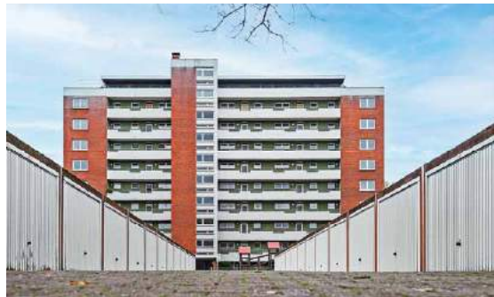
Das Wohnhaus Hasselbreite 1 kurz vor dem Abriss
