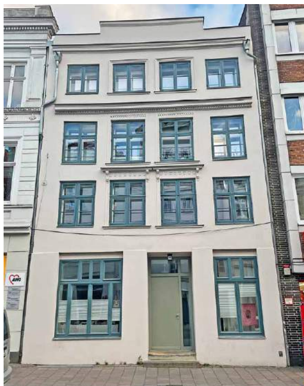
Wurde von der Grundstücks-Gesellschaft Trave aufwendig saniiert: Große Burgstraße 53
