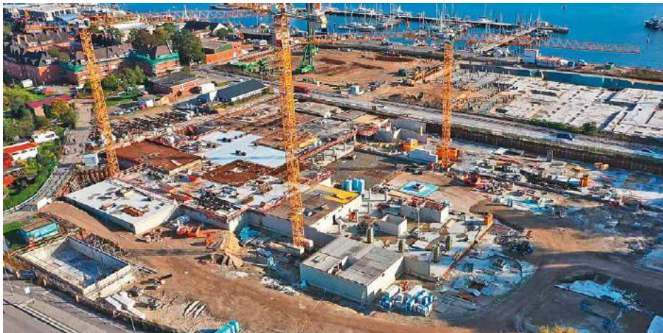
Luftaufnahme der Baustelle vom Oktober 2021: Die TRAVE-Häuser sind bereits im Bau.
