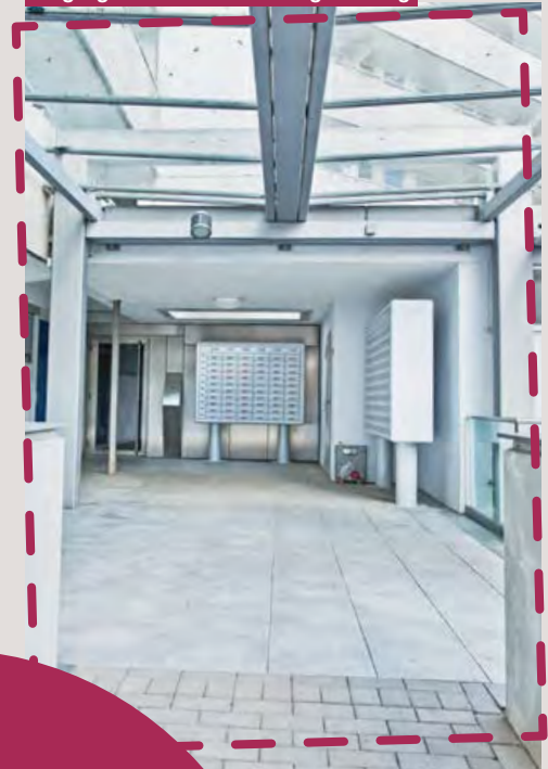
Eingangsbereich nach der Umgestaltung
